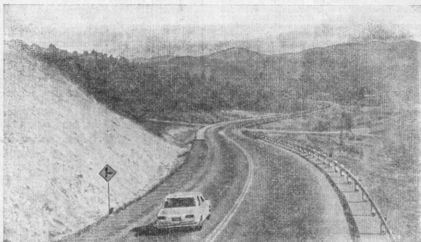
Рис. 2. Горный участок дороги Лампанг — Чианграй
